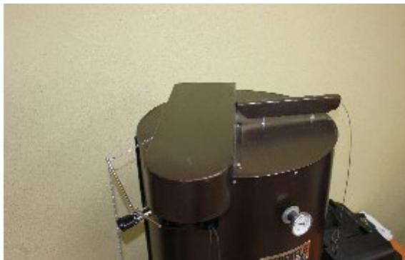
Клапан предназначен для защиты твердотопливных котлов от перегрева. Когда давление воды достигает опасного уровня, клапан открывается, в результате чего, производится аварийный выброс теплоносителя . Клапан должен быть установлен в верхней части котла возле дымохода
